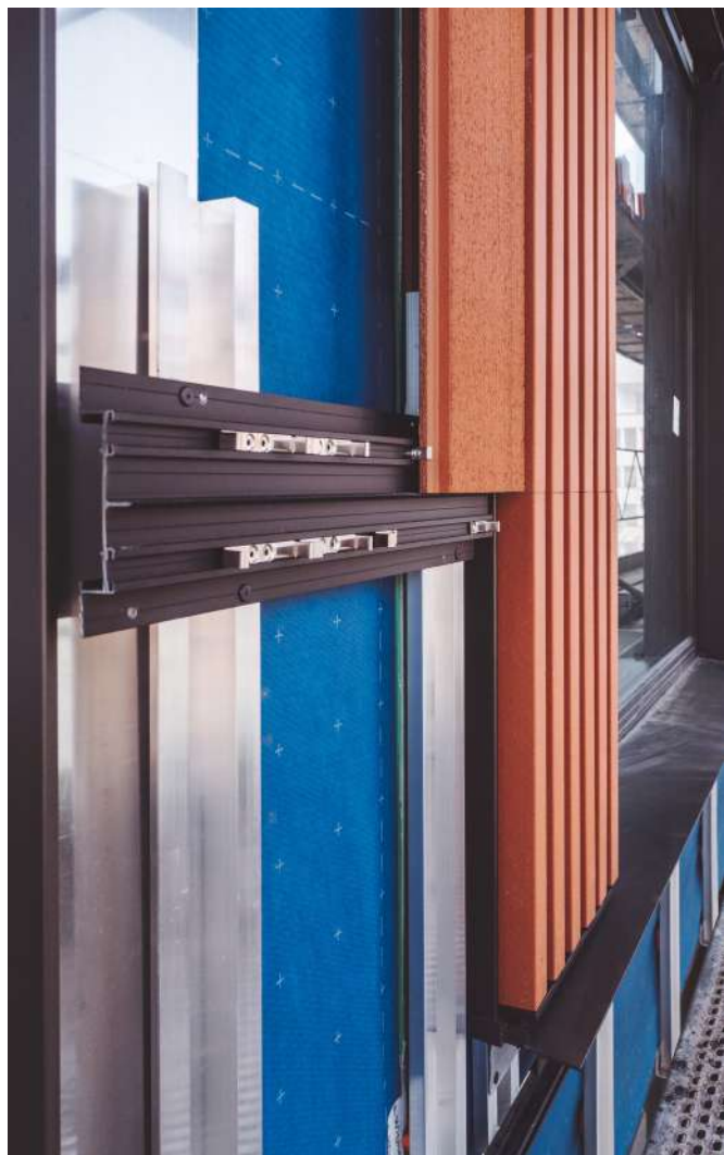
Aufbau hinterlüftete Fassade
