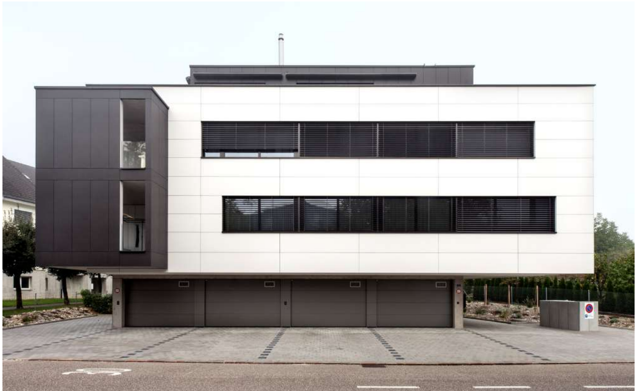
Neubau Mehrfamilienhaus, Frick
