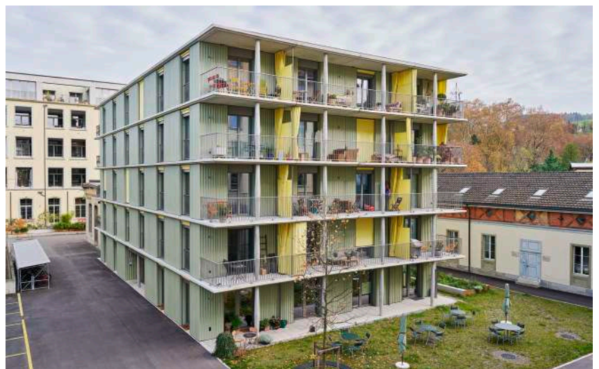
Neubau Kesselhaus Kunzareal, Windisch
