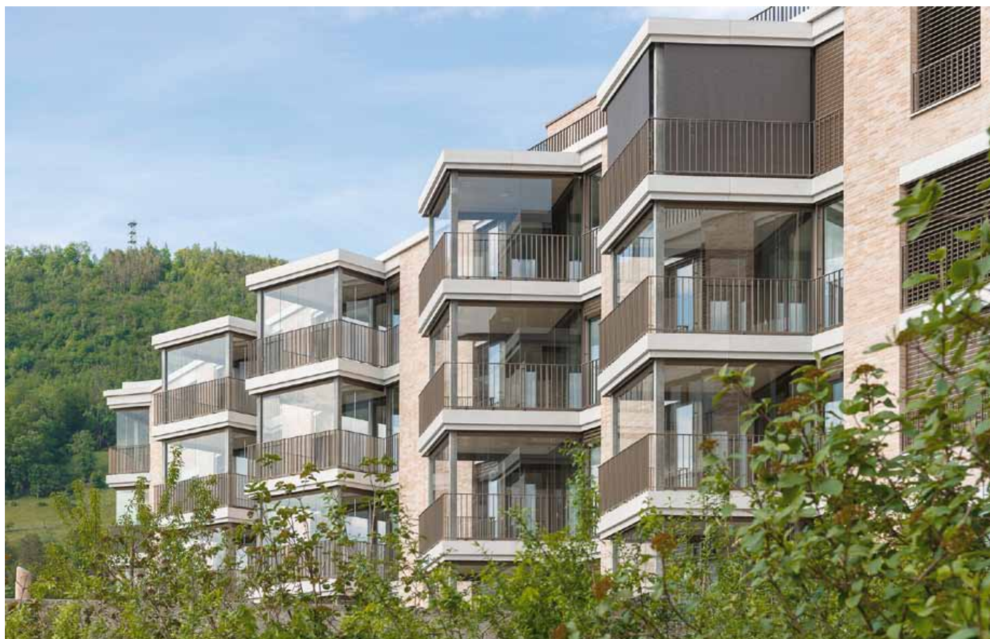
Balkonbrüstungen in Glasfaserbeton
