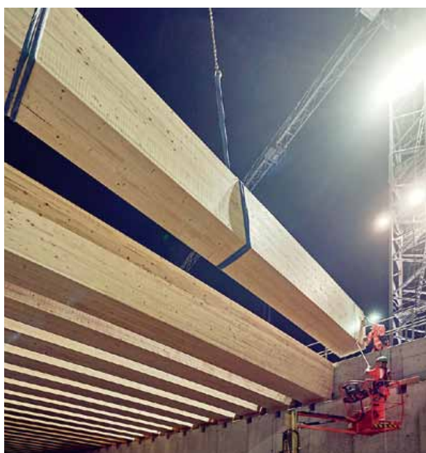
1'835 m 2 druckimprägnierte CLT-Platten über den Trägern
