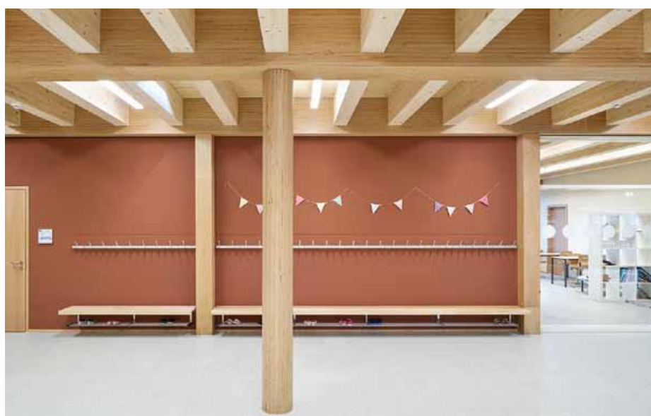
Stütze und Unterzug in Baubuche, sichtbare Balkenlage in Fichte/Tanne und Akustikelement
