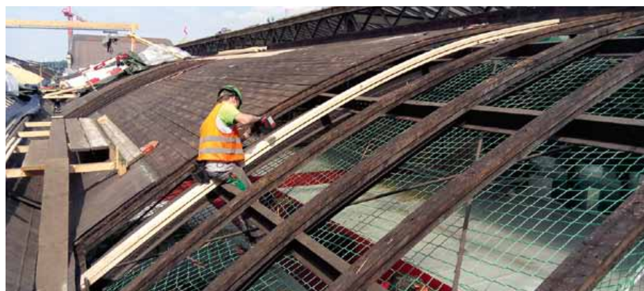
Montage neuer Sparren unter Einhaltung der strengen Sicherheitsvorschriften
