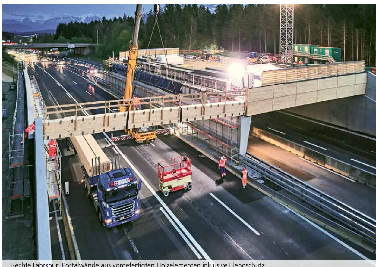
1'835 m 2 druckimprägnierte CLT-Platten über den Trägern
