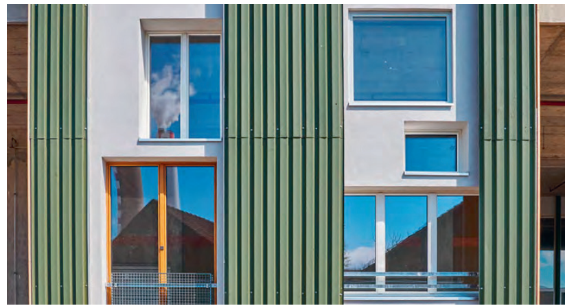
Bei der Aussenfassade sind zusätzlich hinterlüftete Trapezbleche (45 mm) angebracht. Man sieht es der Fassade nicht an, dass sie von der Dämmung bis zum Trapezblech aus gebrauchtem Material besteht. Ein Mock-up überzeugte die Bauherrschaft schliesslich.
