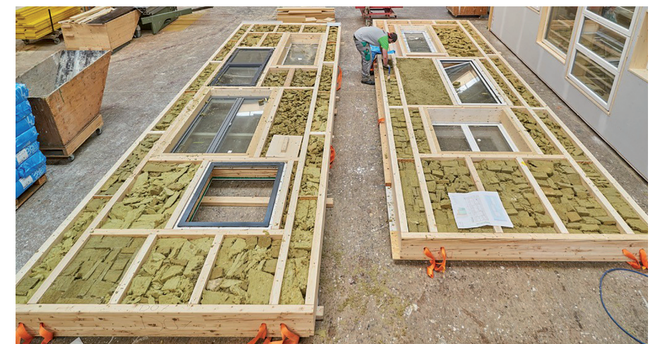
Blick in die Montagehalle der Husner AG Holzbau: Insgesamt 150 Kubikmeter gebrauchte Steinwolle landen als Dämmung in den Holzelementen. Verbleibende Hohlräume werden mit Steinwollgranulat gefüllt.
