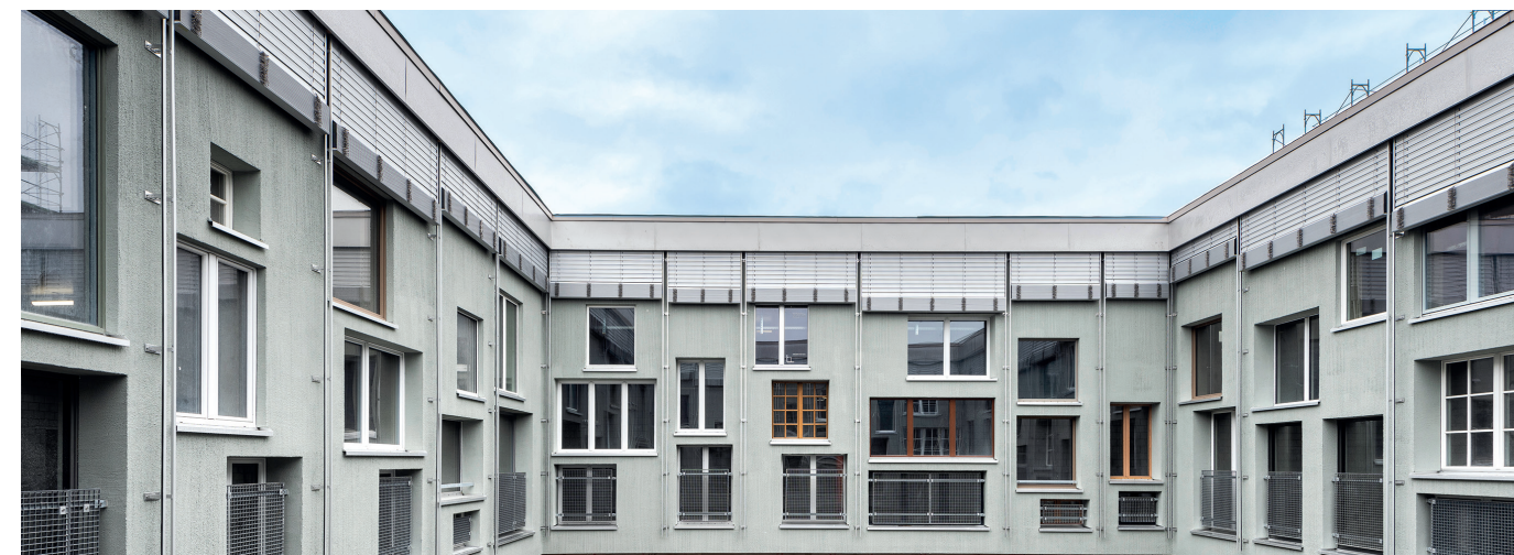
Der Blick in den Innenhof: Die Fassade in Holzelementbauweise wurde so geplant, dass sie Fenster in unterschiedlichsten Grössen aufnehmen kann.
