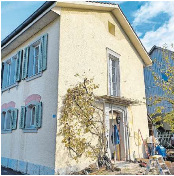
Rechts des Einganges der Mikwe wird ein Hublift angebaut, der das Gebäude in Endingen rollstuhlgängig macht. Bild: Stefanie Garcia Lainez
