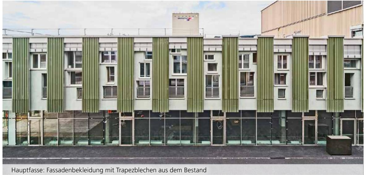
Hauptfassade: Fassadenbekleidung mit Trapezblechen aus dem Bestand
