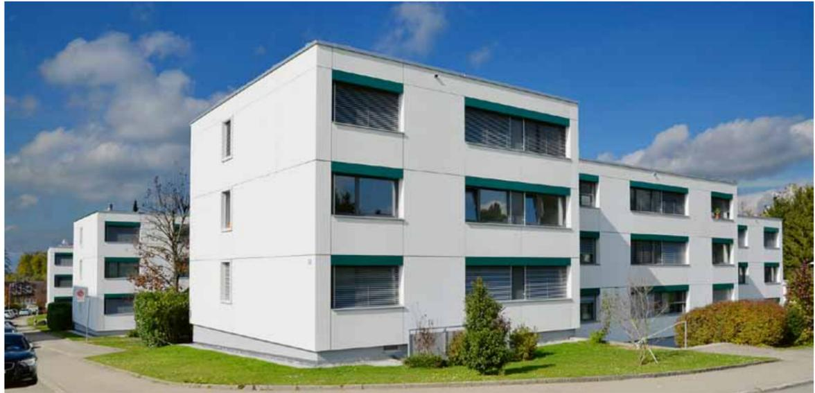
Wo einst Weisszement dominierte, prägt heute moderner Glasfaserbeton die Fassade der Wohnüberbauung Rietholz in Zollikerberg. Optisch ist kaum ein Unterschied zu erkennen – energetisch hat die Fassadensanierung die Bauten entscheidend aufgewertet.
