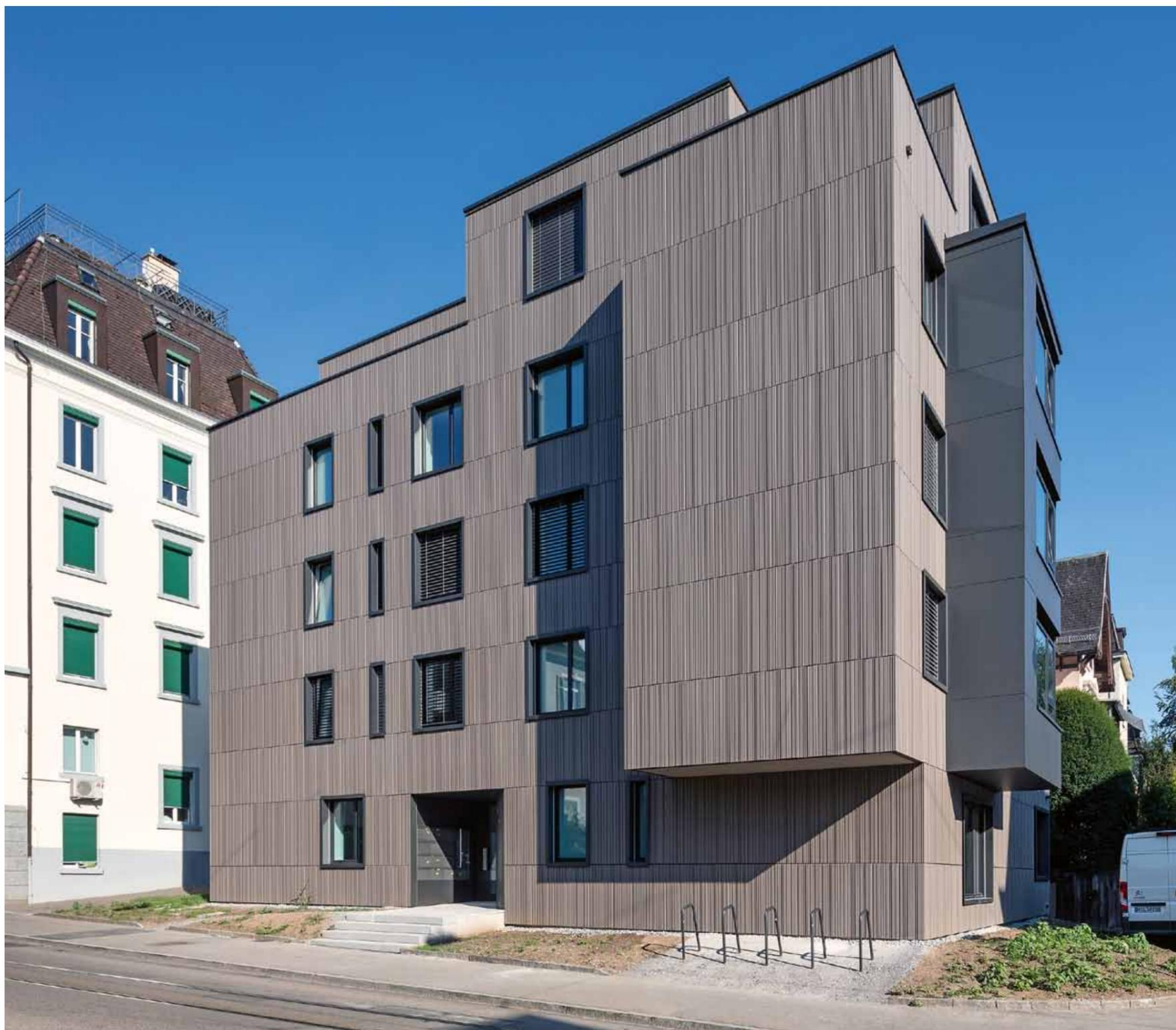
Der Massivbau an der Klosbachstrasse in Zürich hat eine umfangreiche Sanierung erfahren. Innen wurde das Gebäude vollständig entkernt und die Wohnungsgrundrisse an die heutigen Bedürfnisse angepasst. Mit der Aufstockung ist das Wohnhaus um ein Attikageschoss in die Höhe gewachsen. Innen- und Aussenwände sowie das Dach des Attikageschosses sind in leichter Holzelementbauweise gefertigt. Der kubische Ausdruck blieb dabei erhalten.
