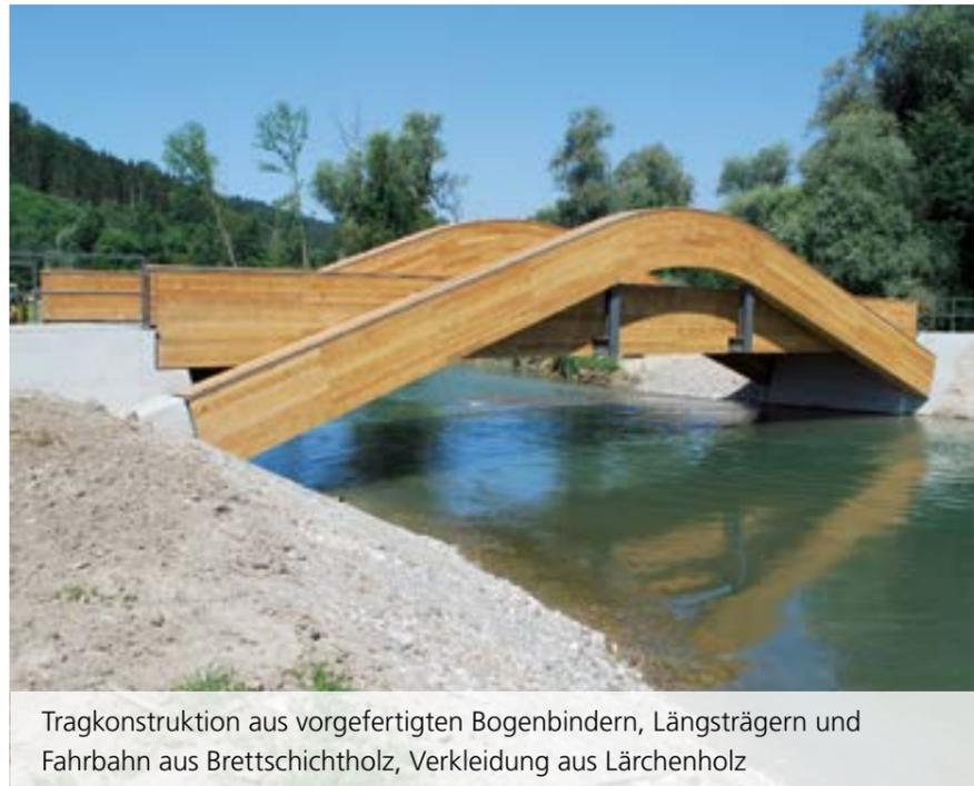
Tragkonstruktion aus vorgefertigten Bogenbindern, Längsträgern und Fahrbahn aus Brettschichtholz, Verkleidung aus Lärchenholz
